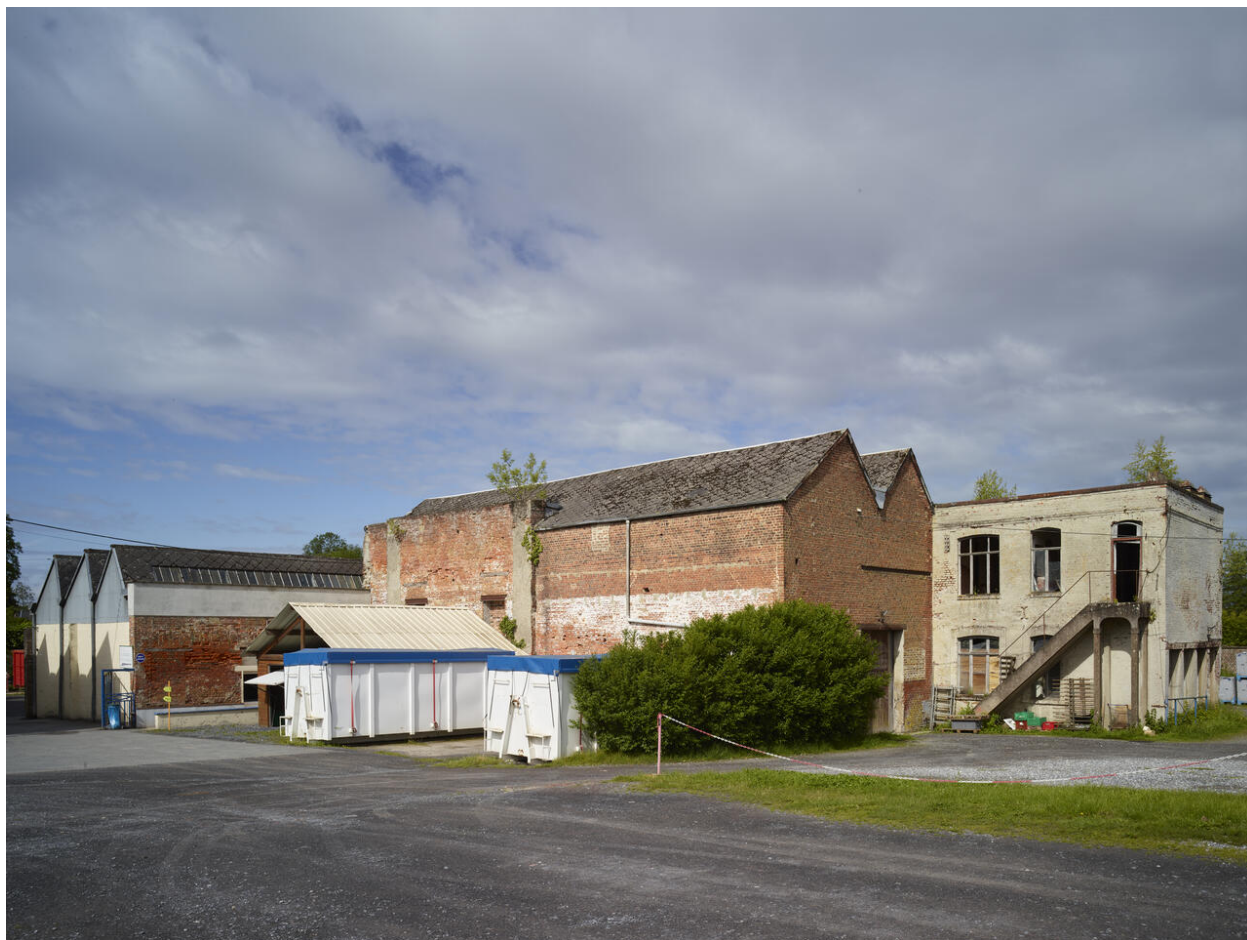
Vue d'ensemble de la salle des générateurs et des ateliers attenants, vers l'ouest.
