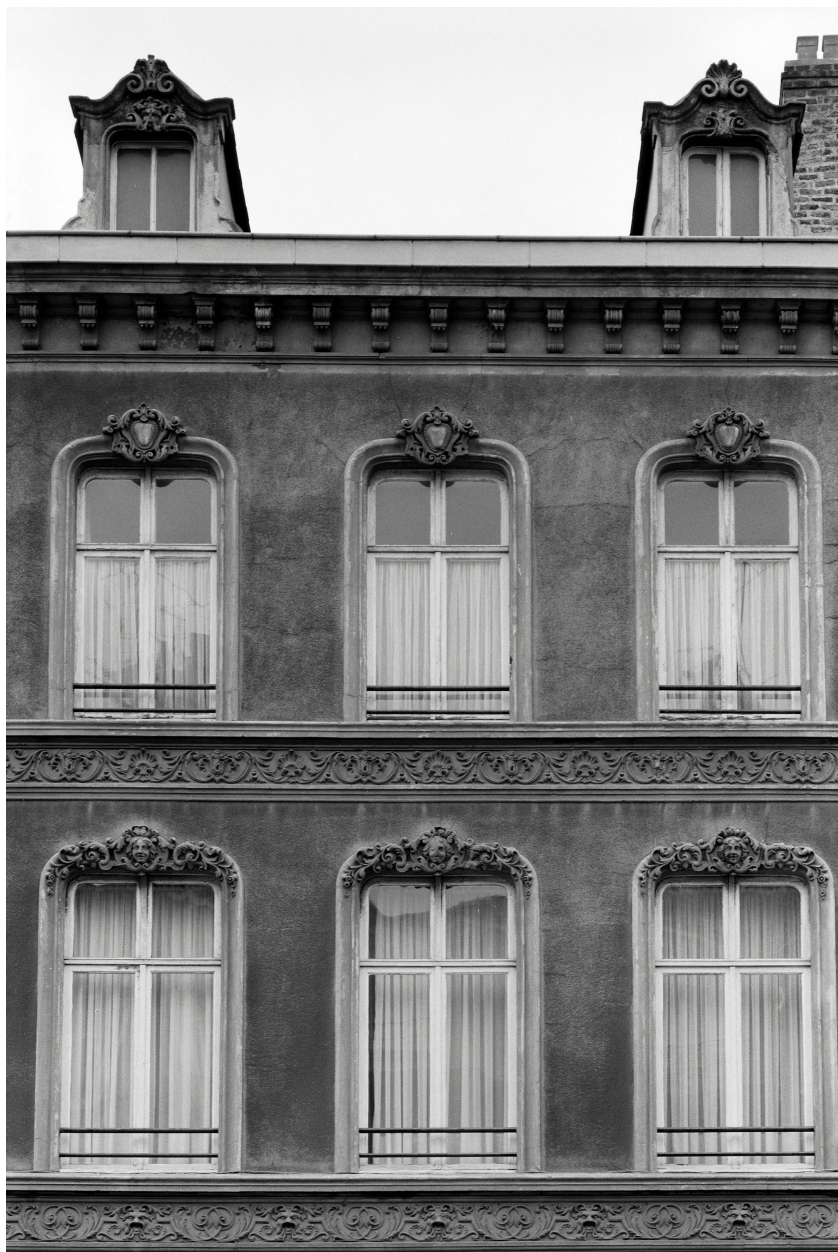
1er étage, 2e étage, 3 travées centrales, fenêtres.
