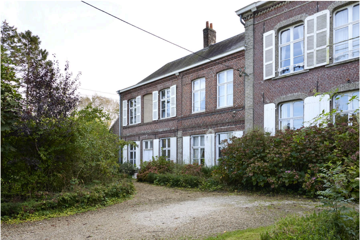
Module est. Façade principale.
