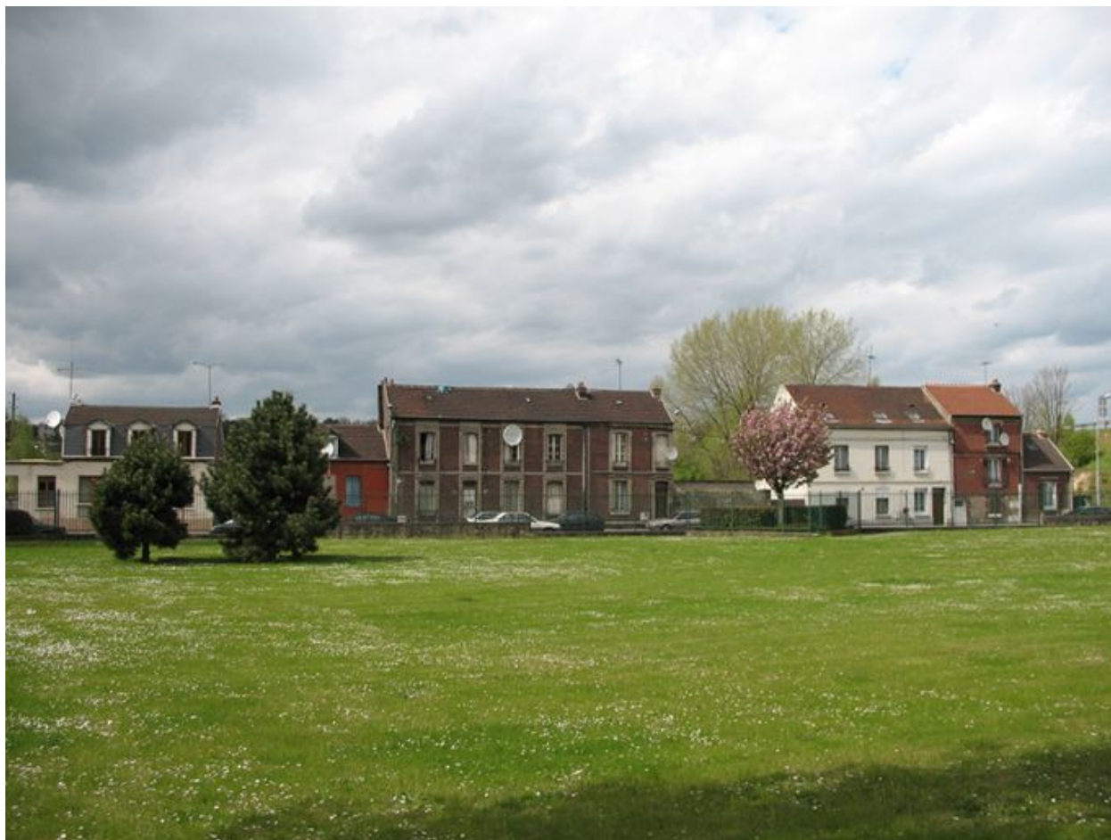
Maisons ouvrières construites face à l'usine d'Henri Joret.
