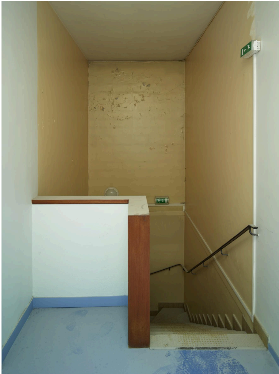
Deuxième étage, palier et escalier.
