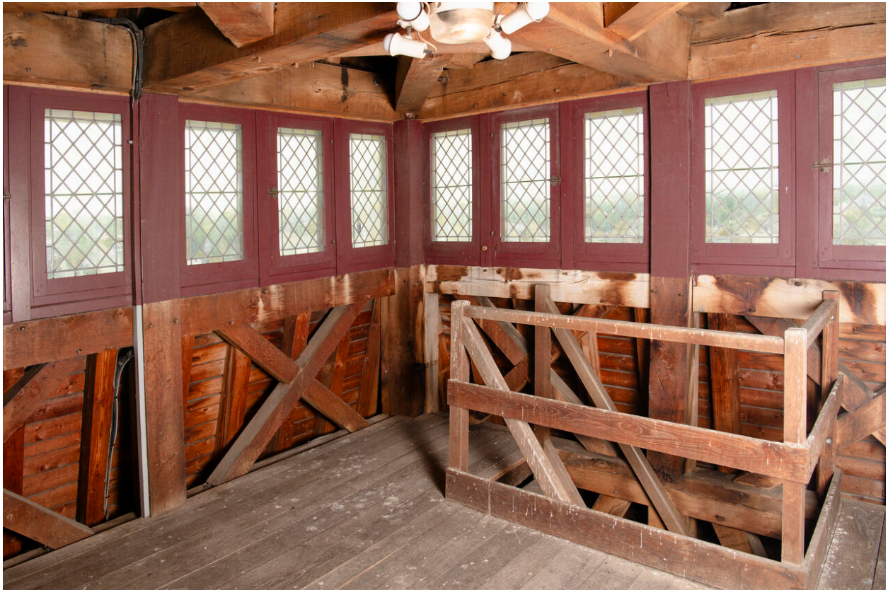
Vue générale de la loge du guetteur.
