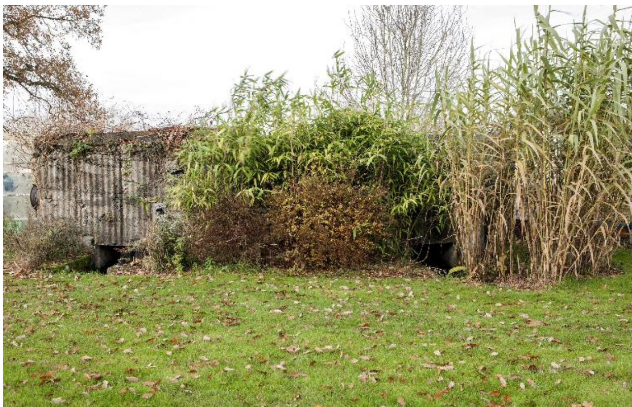
Elévation antérieure, vers le nord-ouest
