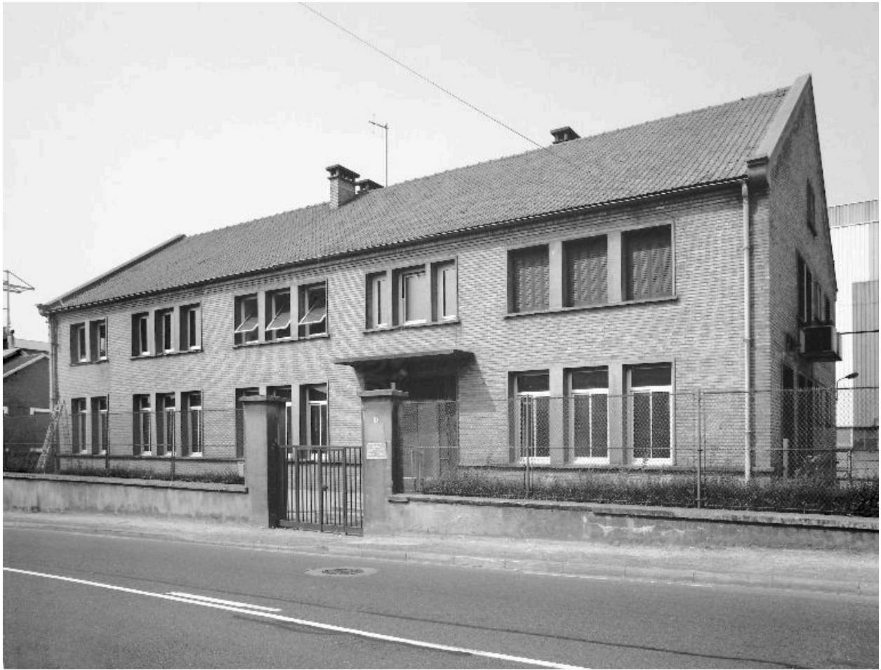
Vue des bureaux, façade est sur la rue.
