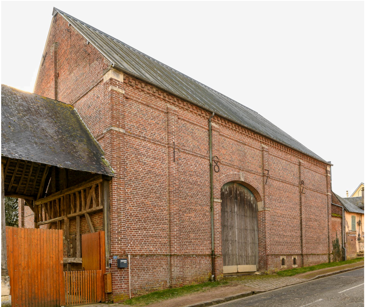
Grange sur rue, date portée "1872", n°35 rue de la Chaussée, vue depuis le nord.
