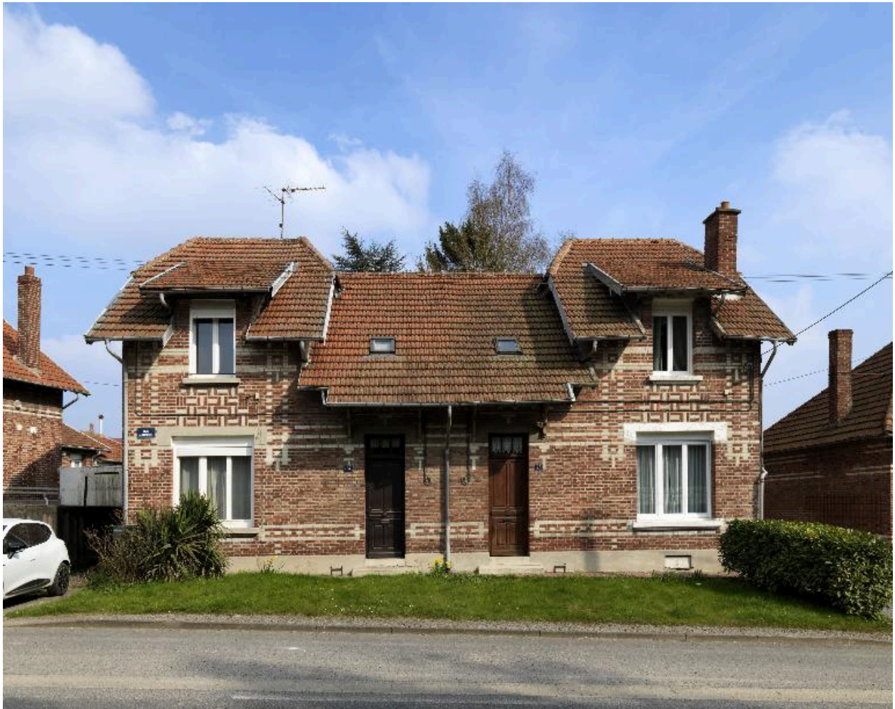
Maison à deux logements (25-26 rue de Roisel).
