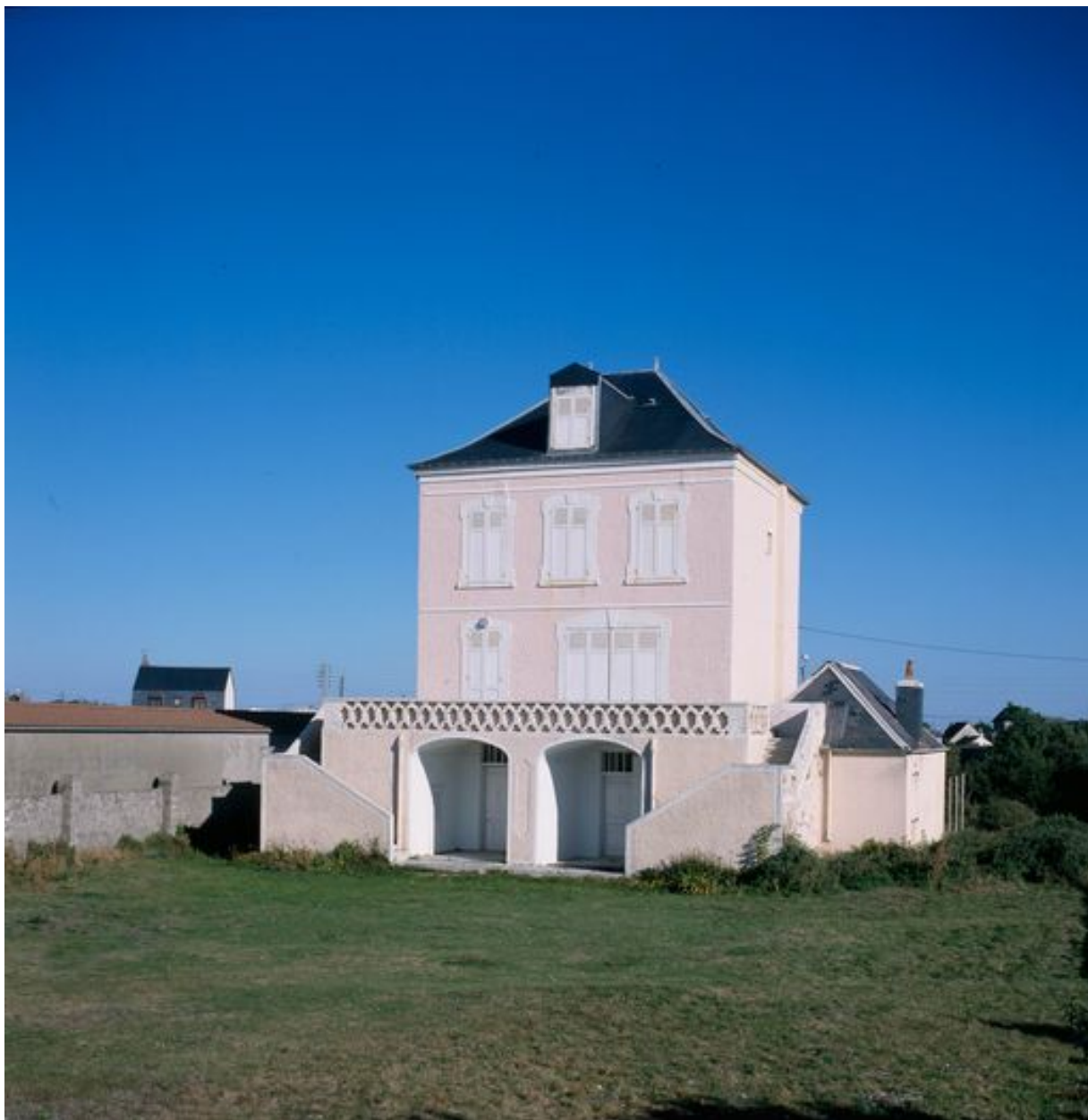
Elévation côté mer.
