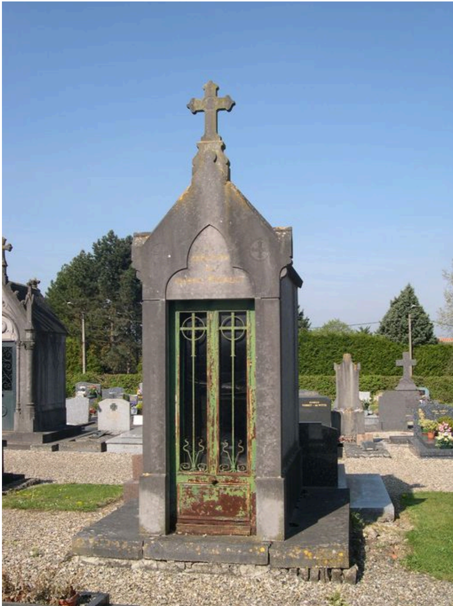
Tombeau (chapelle) exécuté par l'entrepreneur Rombaux Roland.
