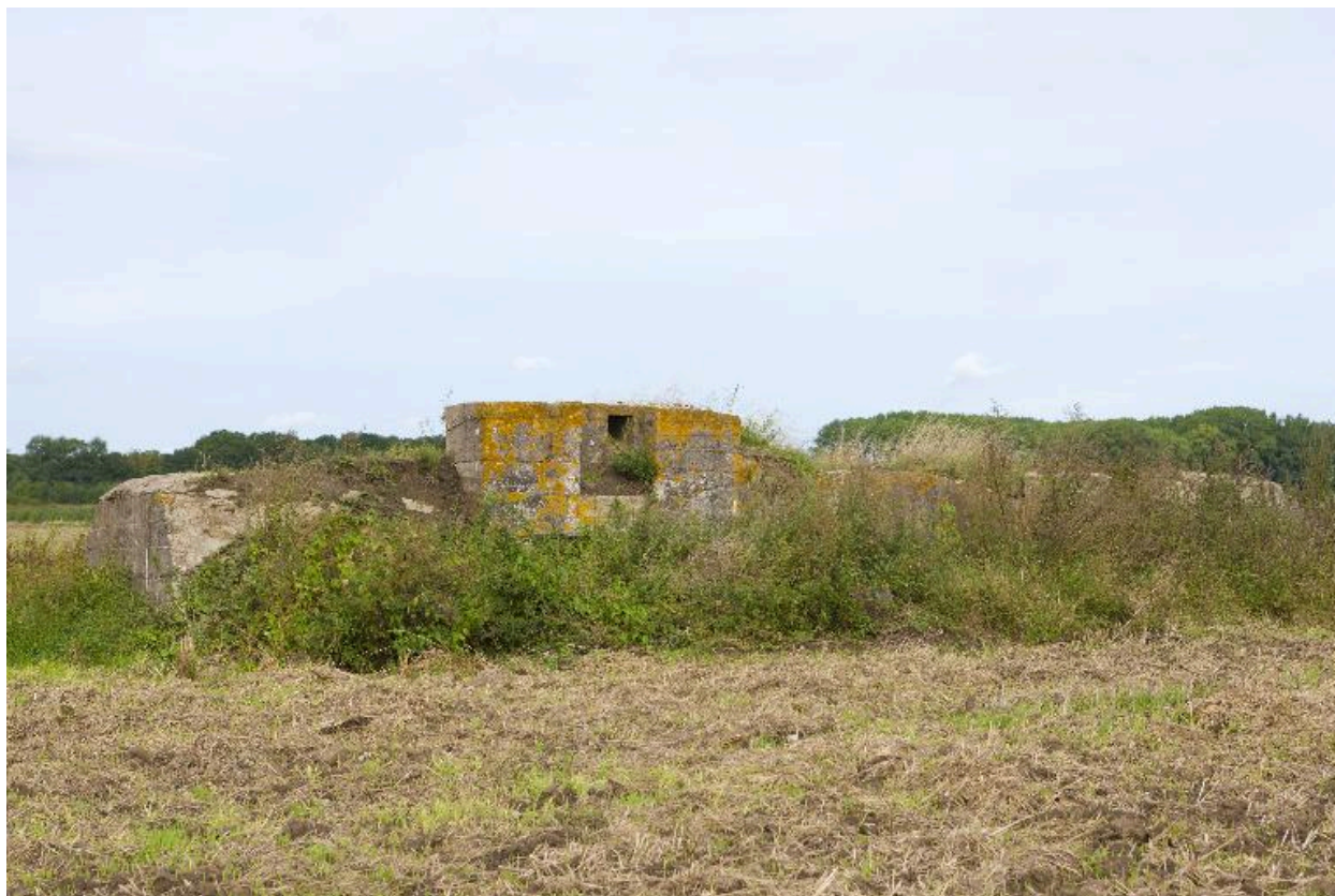
Vue antérieure, vers le nord-ouest
