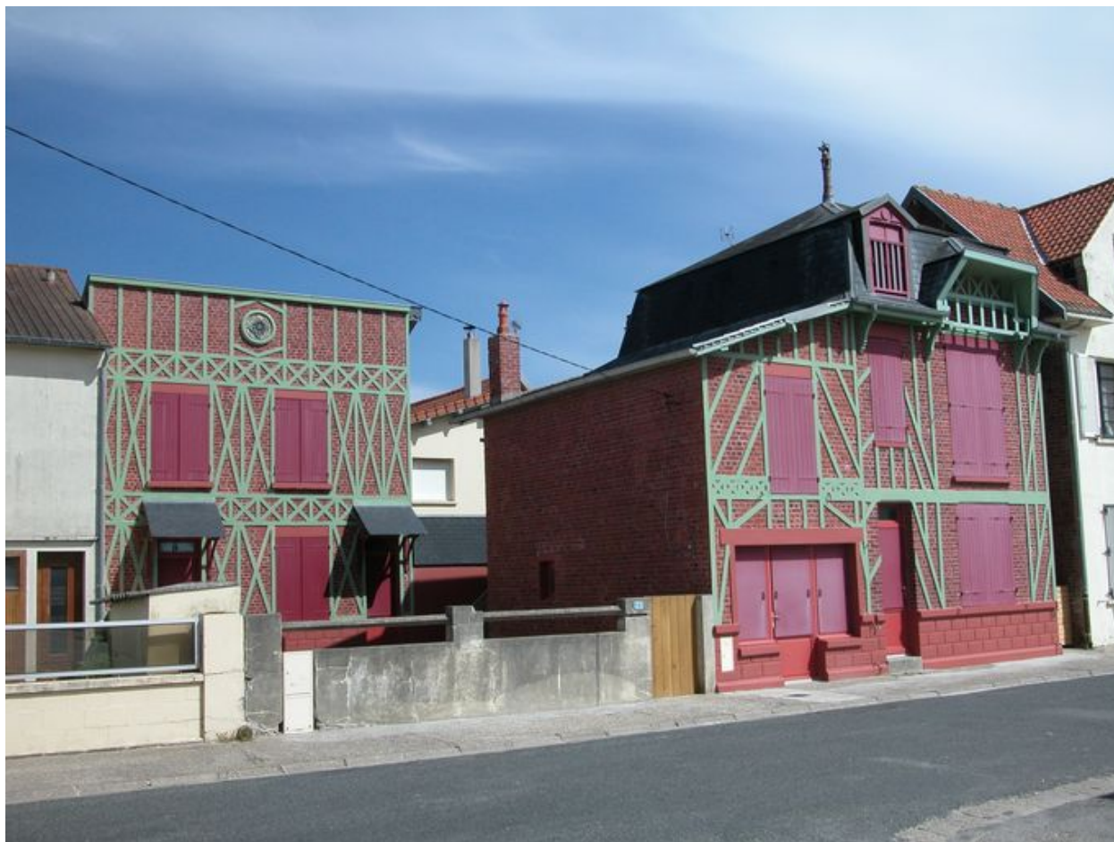
Vue d'ensemble des deux habitations, après restauration.
