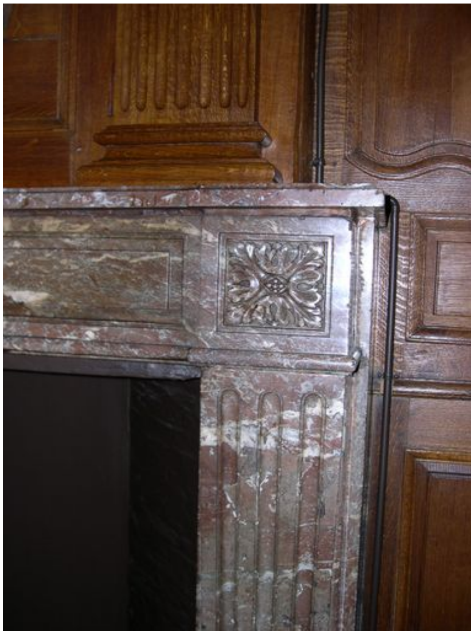
Vue de détail : angle droit, motif en rosace.
