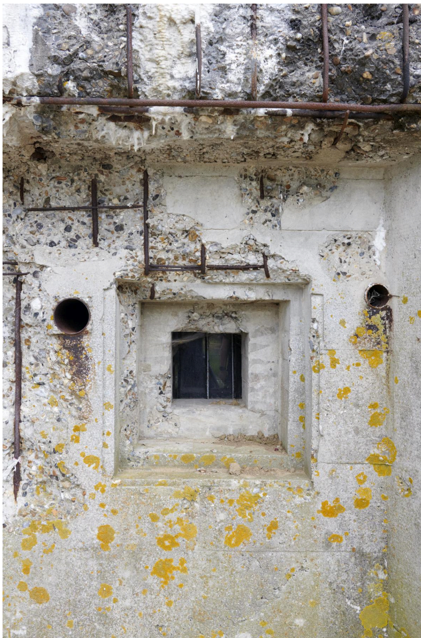
Détail d'un créneau de tir de mitrailleuse.
