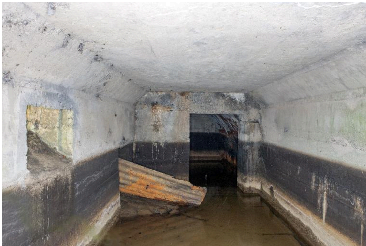
Vue interieure, vers l'ouest
