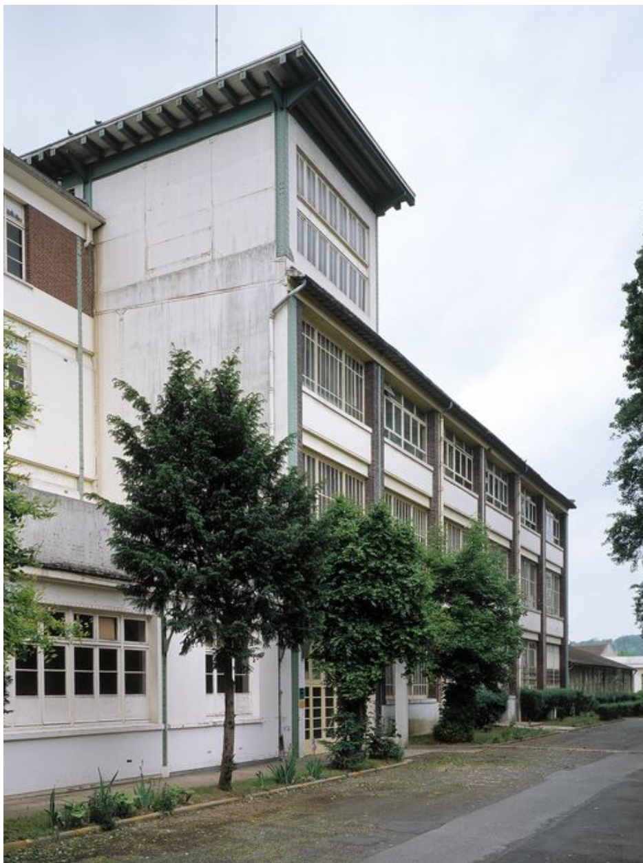
Tour d'escalier du lycée.
