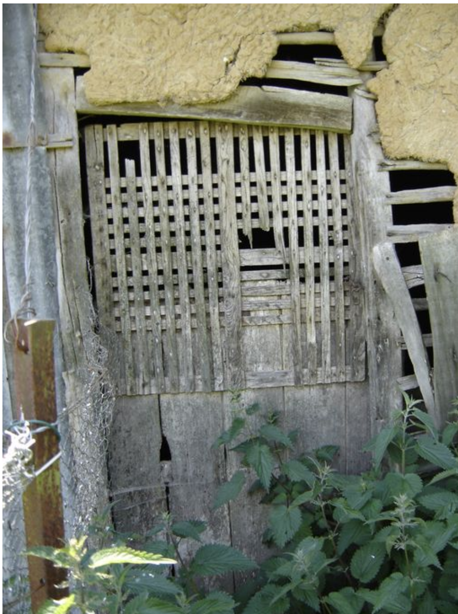
Vue détaillée de la porte de l'abri.
