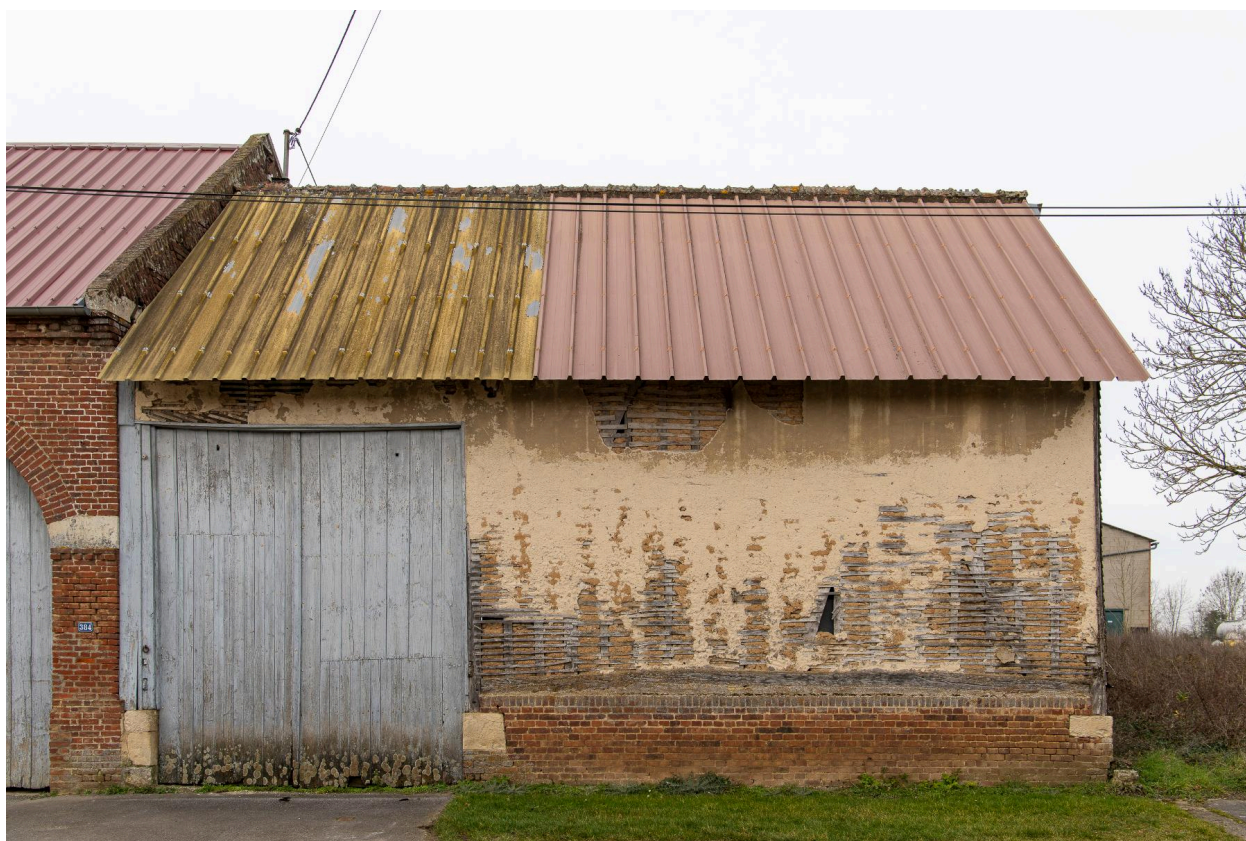
Grange sur rue, n°384 rue des Marronniers, vue depuis l'est.
