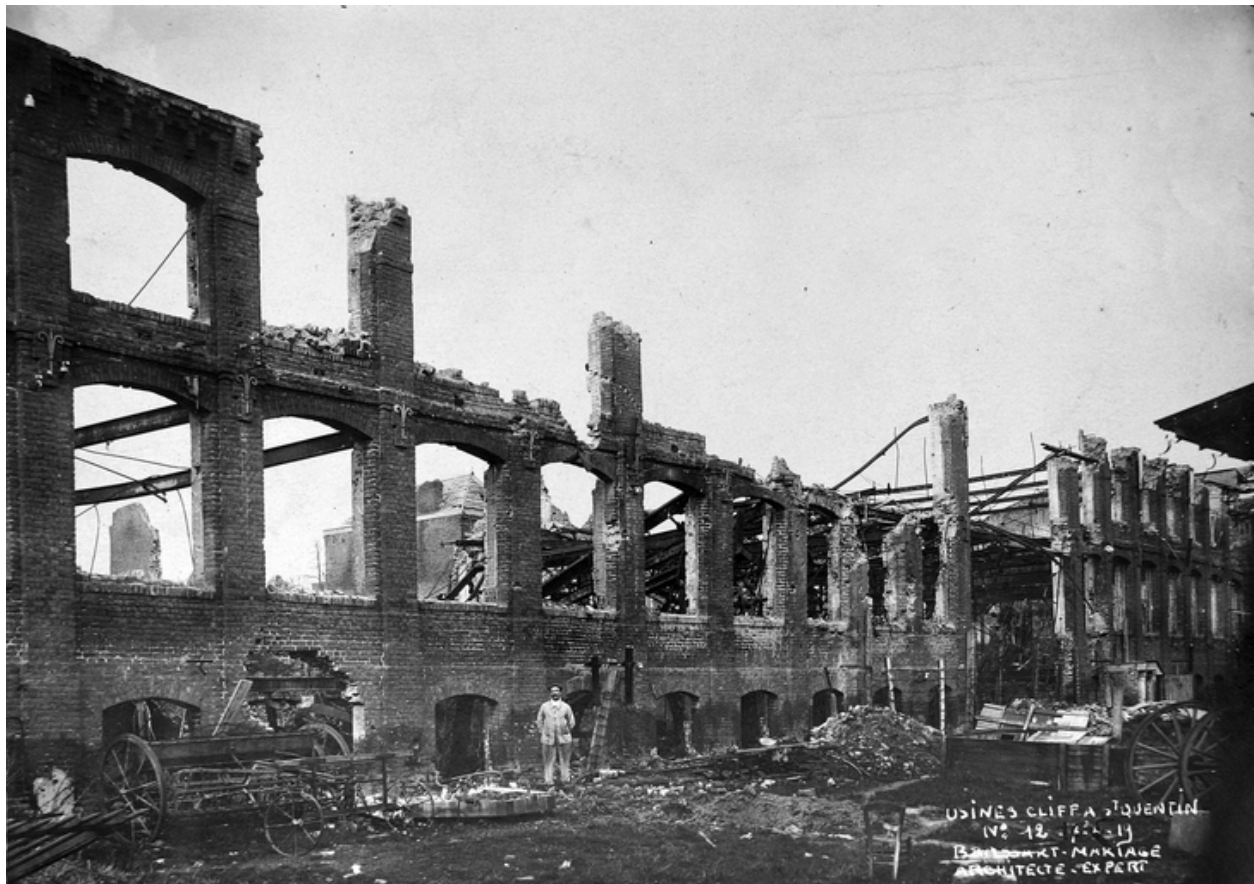
Façade postérieure de l'atelier d'apprêt et pliage, par Brassart-Mariage, mai 1919 (AD Aisne).
