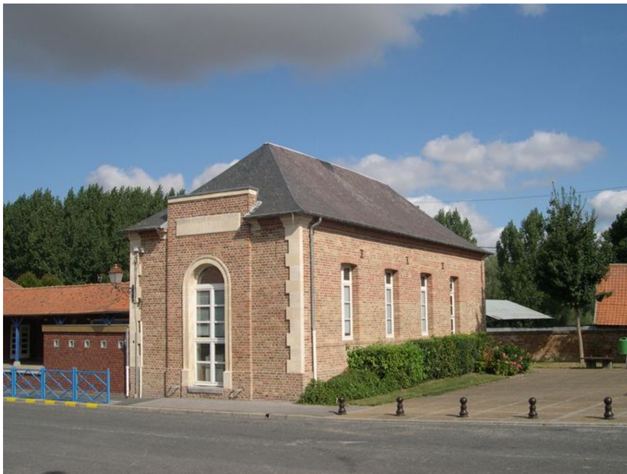
L'école, vue du sud-est.
