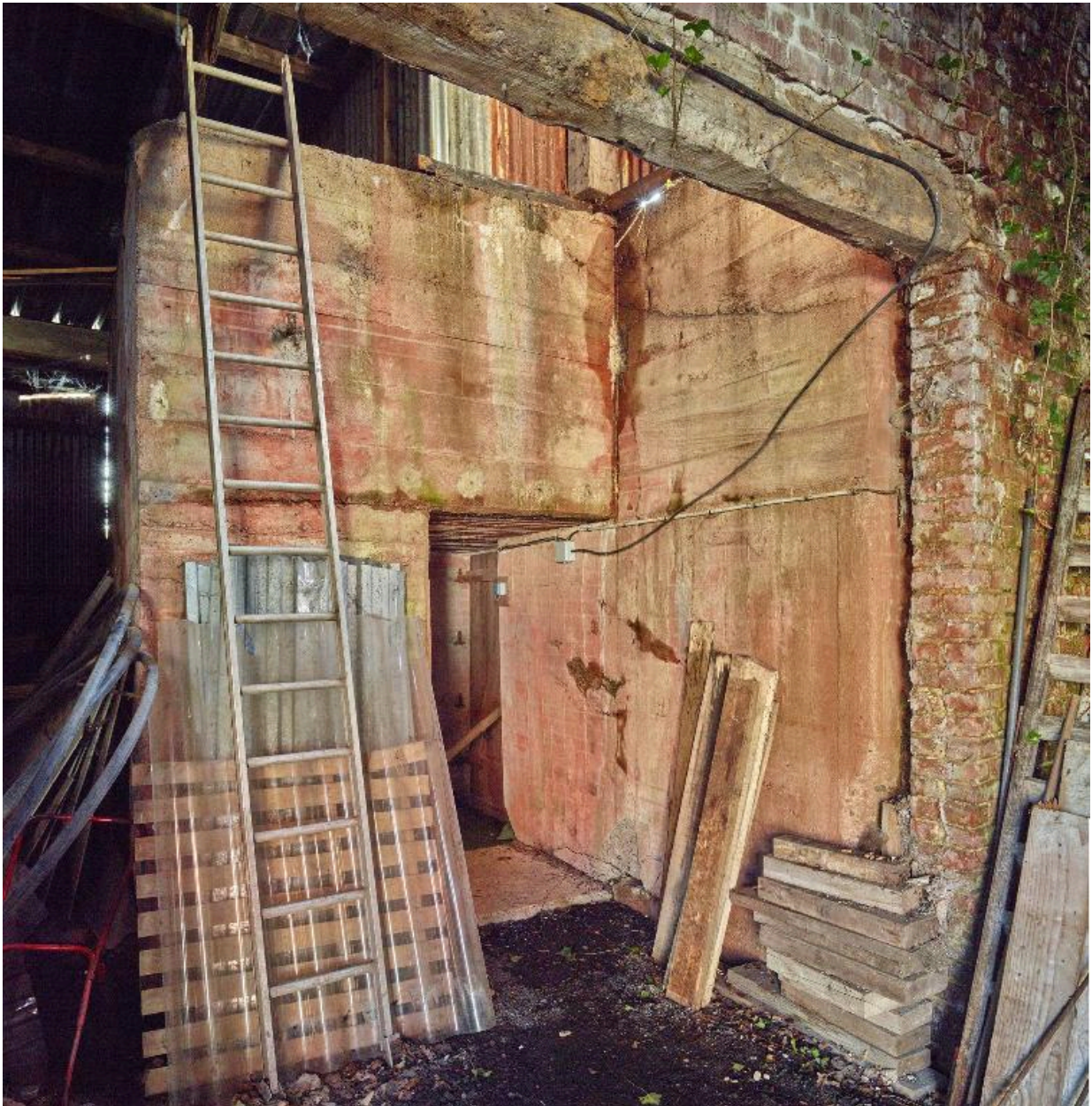
Aile sud de la casemate
