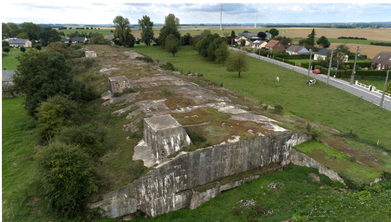
Vue aérienne oblique vers le nord.
