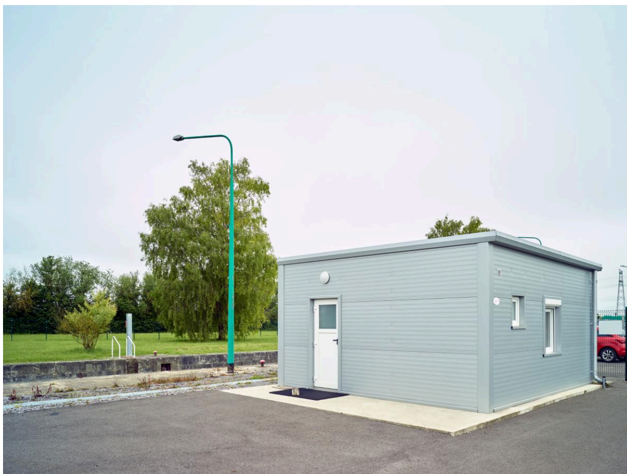
Le nouveau poste de commande.
