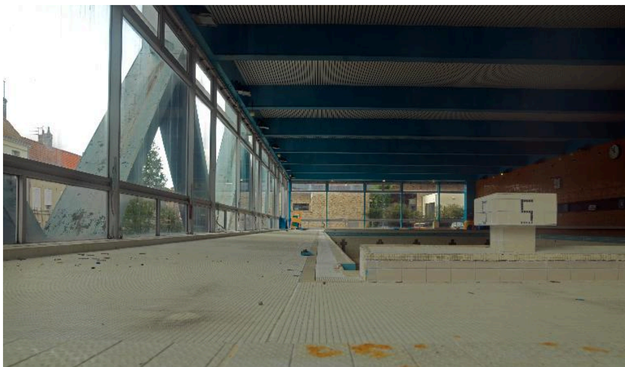
Vue du bassin sportif et des plages, côté baies vitrées.
