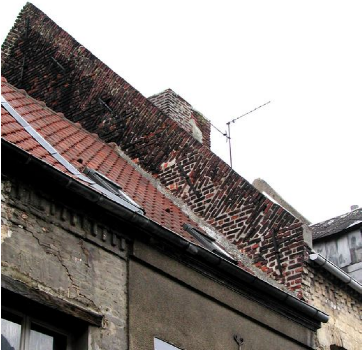
Façade du n° 11, vue partielle, état en 2006 : pignon découvert, traitement du rampant en épis.
