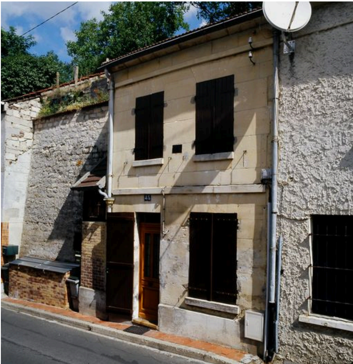
Habitation semi-troglodytique rue des Hauts-Tufs à Creil.
