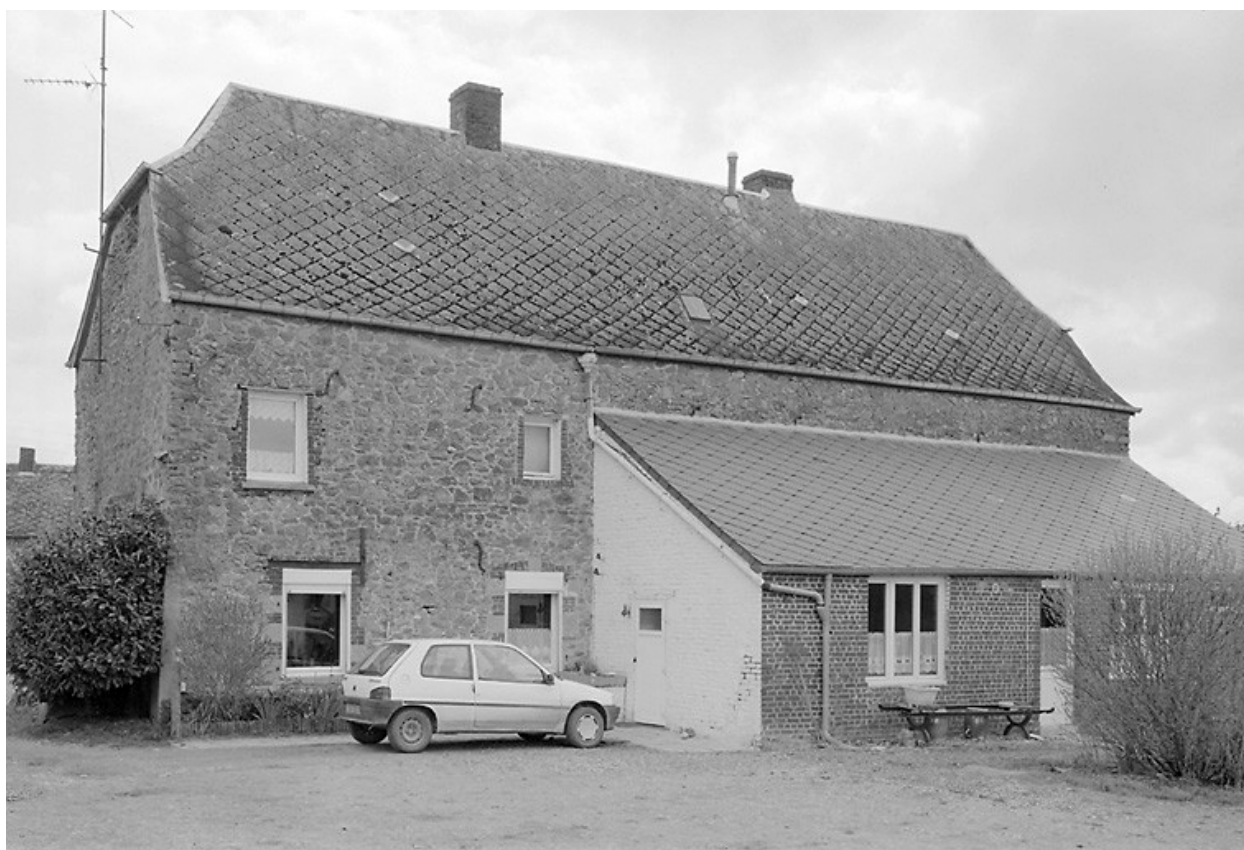
Vue de l'élévation postérieure du logis.
