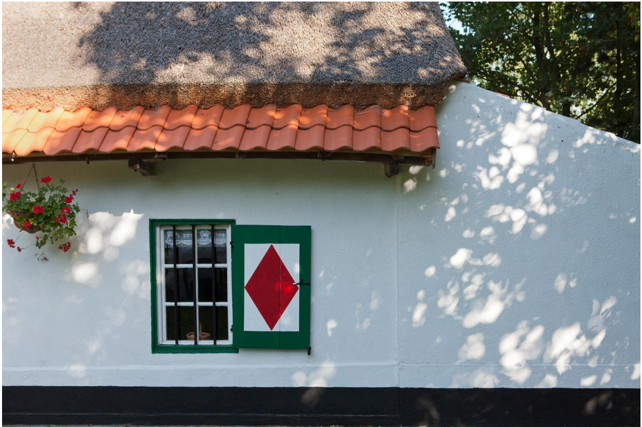
Détail de la façade sud. Fenêtre, chaume et tuiles.
