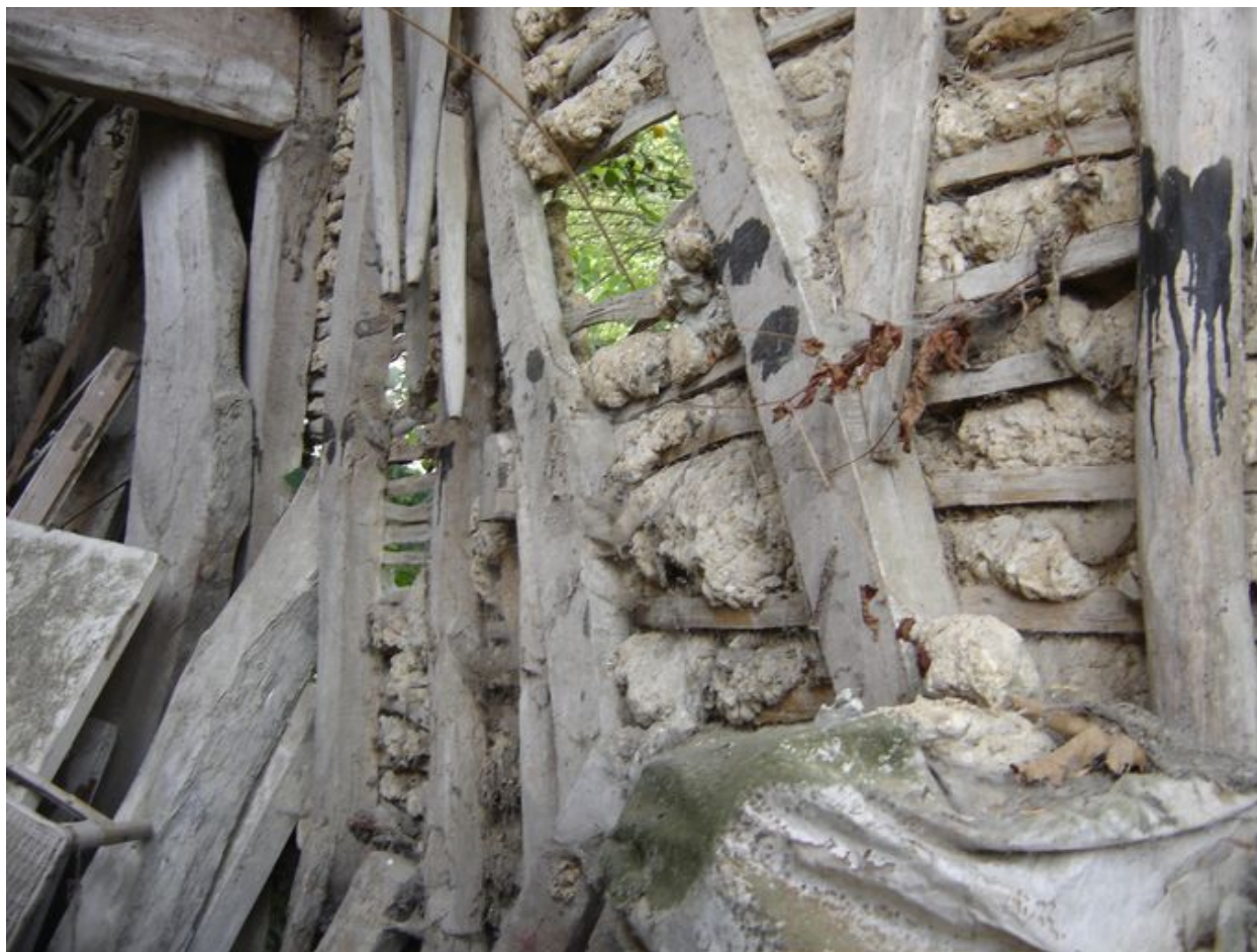
Vue intérieure d'un des deux murs gouttereaux.
