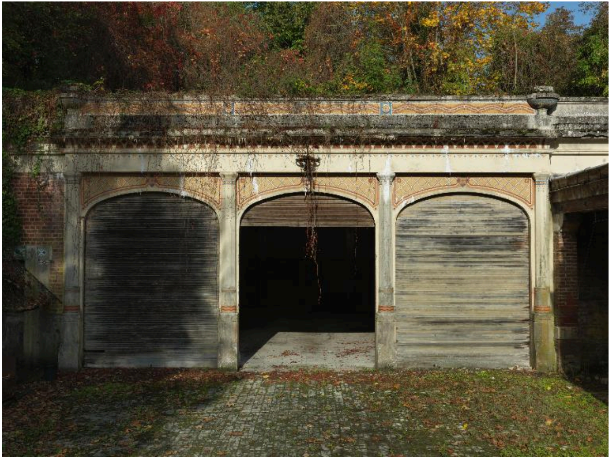
Entrée du garage automobile.
