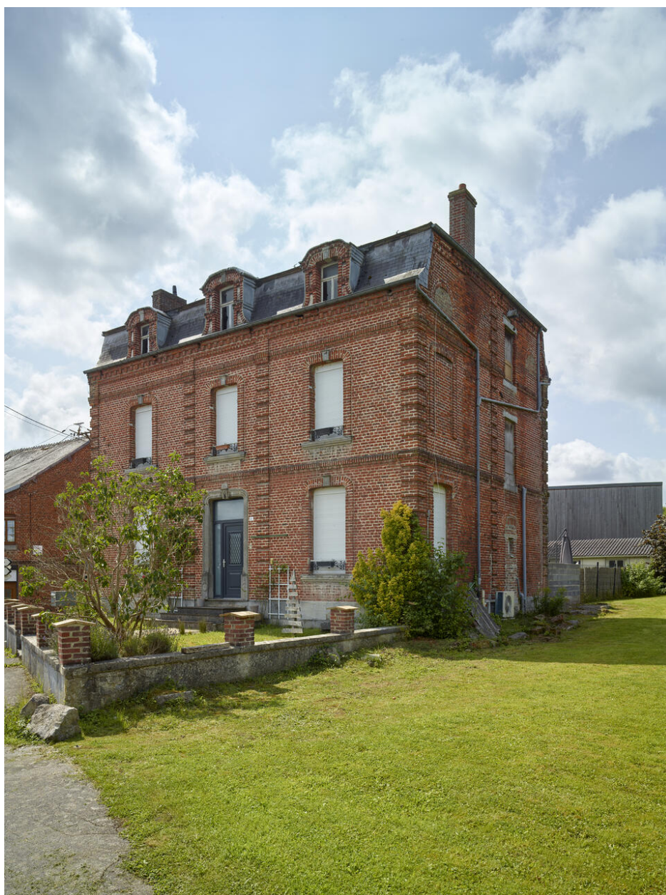
Vue de trois quarts vers le sud-est.
