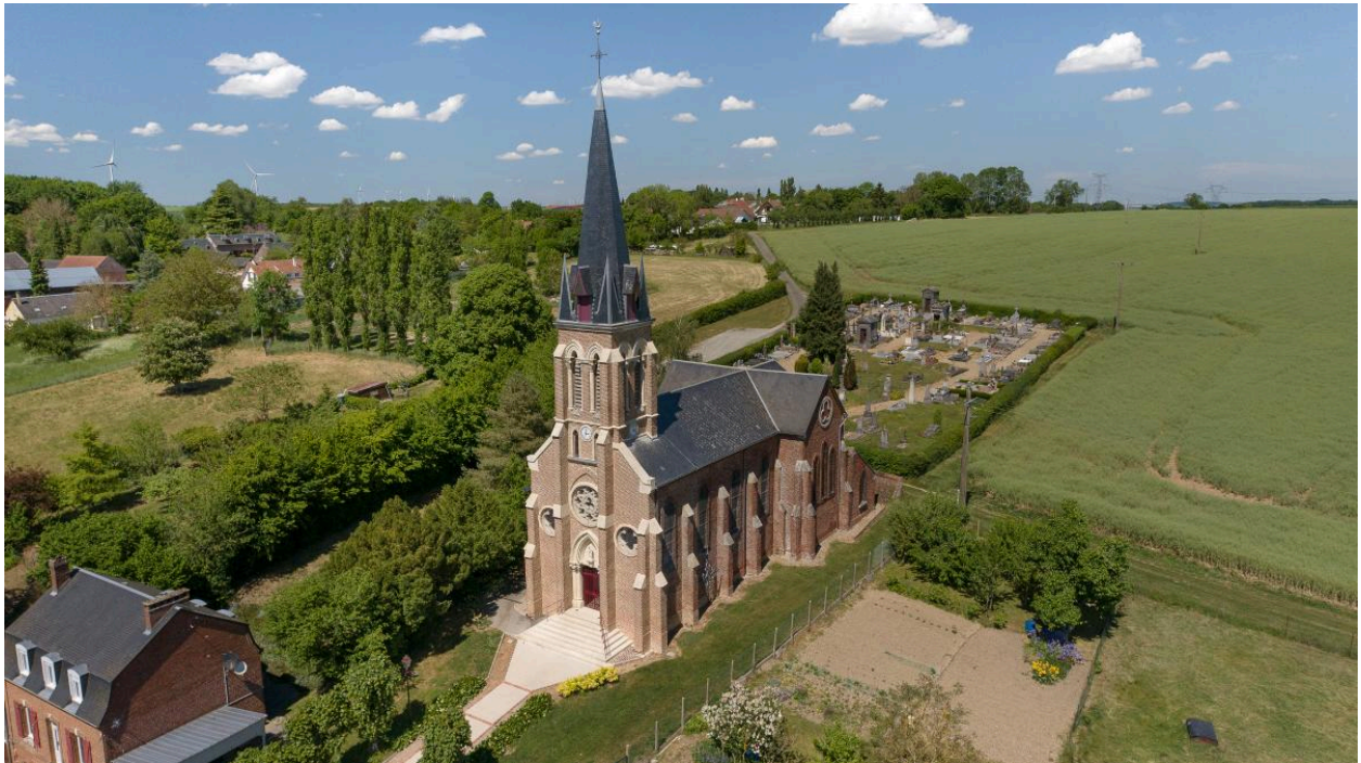
Vue aérienne de l'église depuis le sud-ouest.
