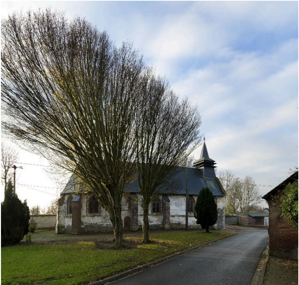
Vue générale nord-est.
