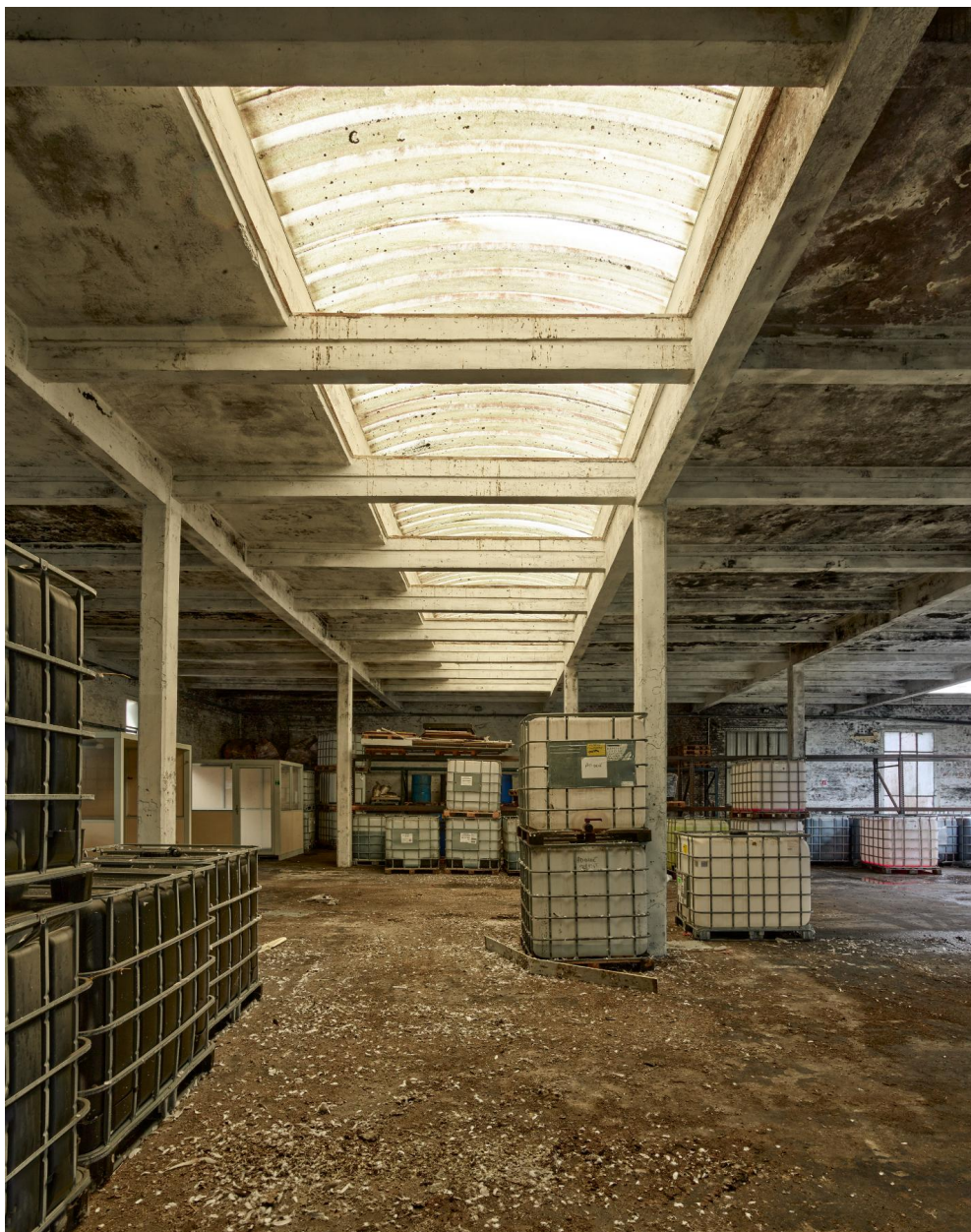
Vue intérieure des magasins en rez-de-chaussée atenant à l'ancien atelier de fabrication (bâtiment K).
