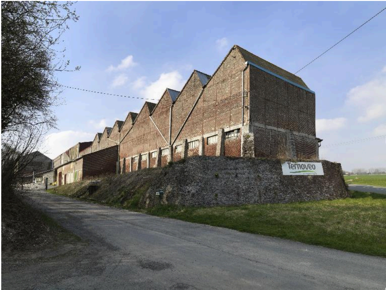
Atelier de traitement des phosphates.
