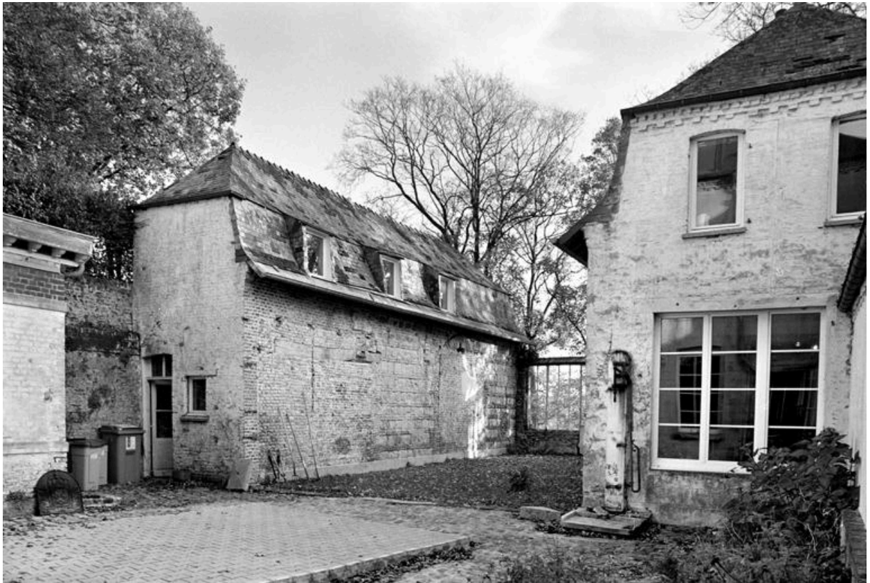
Vue des 2 pavillons, élevés en fond de cour, probablement avec les grès du rempart.
