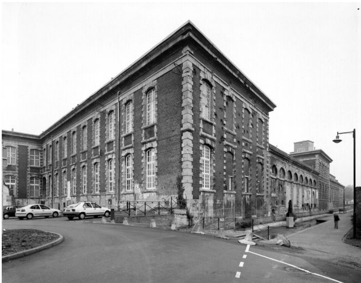
Élévation latérale droite donnant sur le canal de l'Escaut et élévation antérieure du corps de bâtiment fermant la cour des services sur l'avant, vue d'ensemble.
