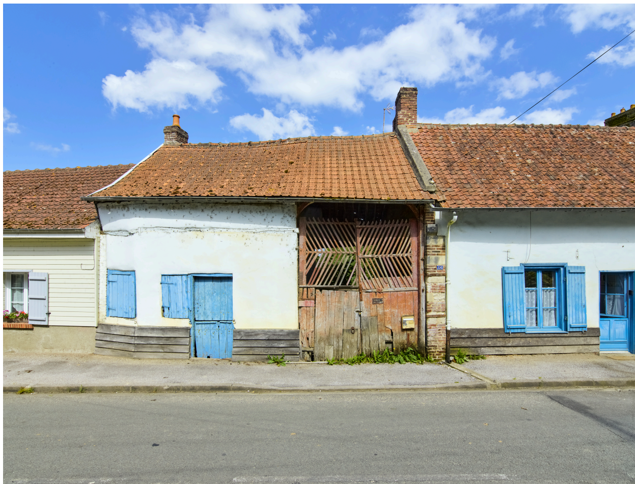
Vue de la grange, depuis l'ouest.
