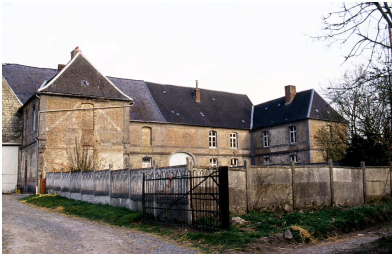
Vue de l'élévation ouest des bâtiments subsistants.
