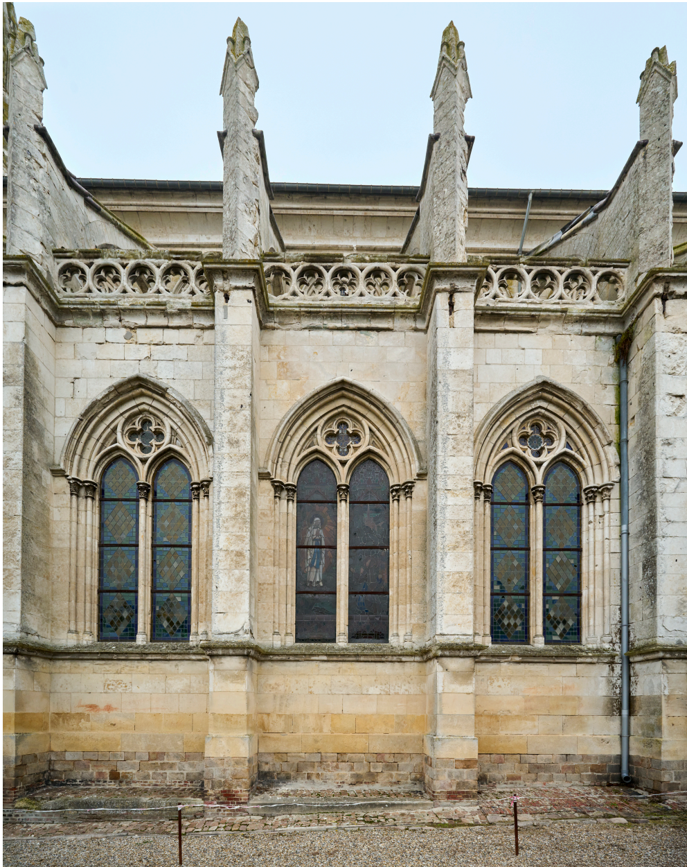
Détail de l'élévation sud de la nef.
