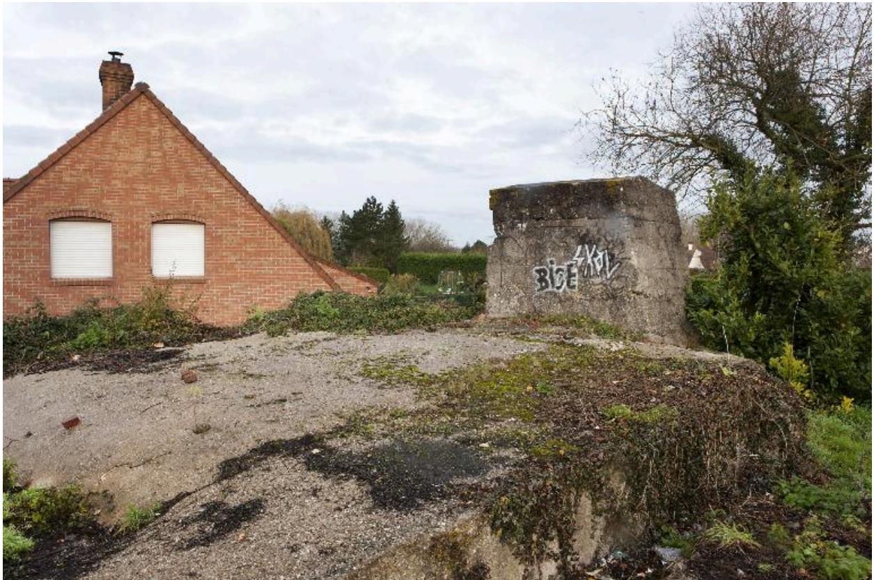
Tourelle de communication optique, vers le nord (au grand angulaire)
