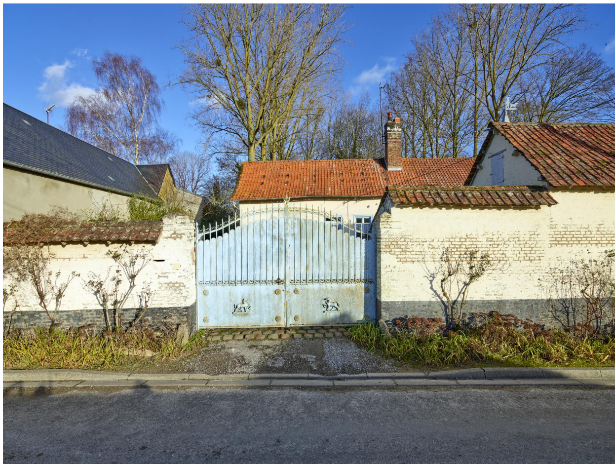
Vue du portail d'entrée de la ferme, depuis l'ouest.
