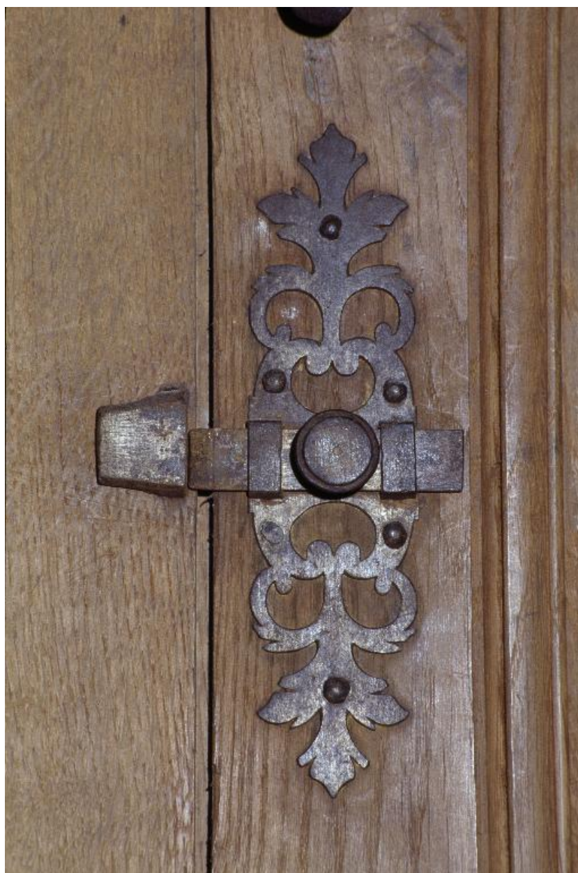
Vue d'un des verrous des vantaux de la porte occidentale.
