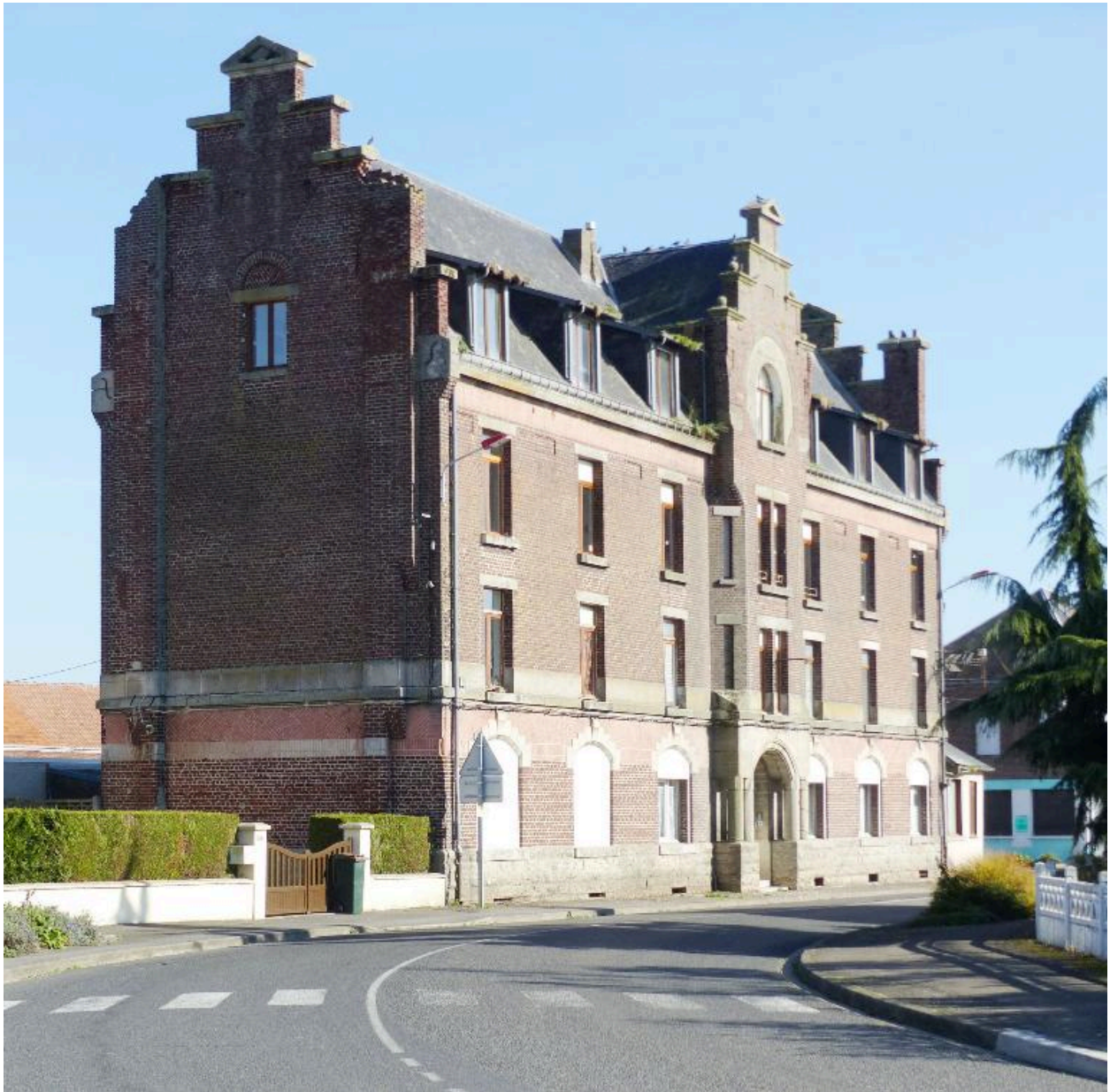
Vue générale, depuis le sud-ouest.
