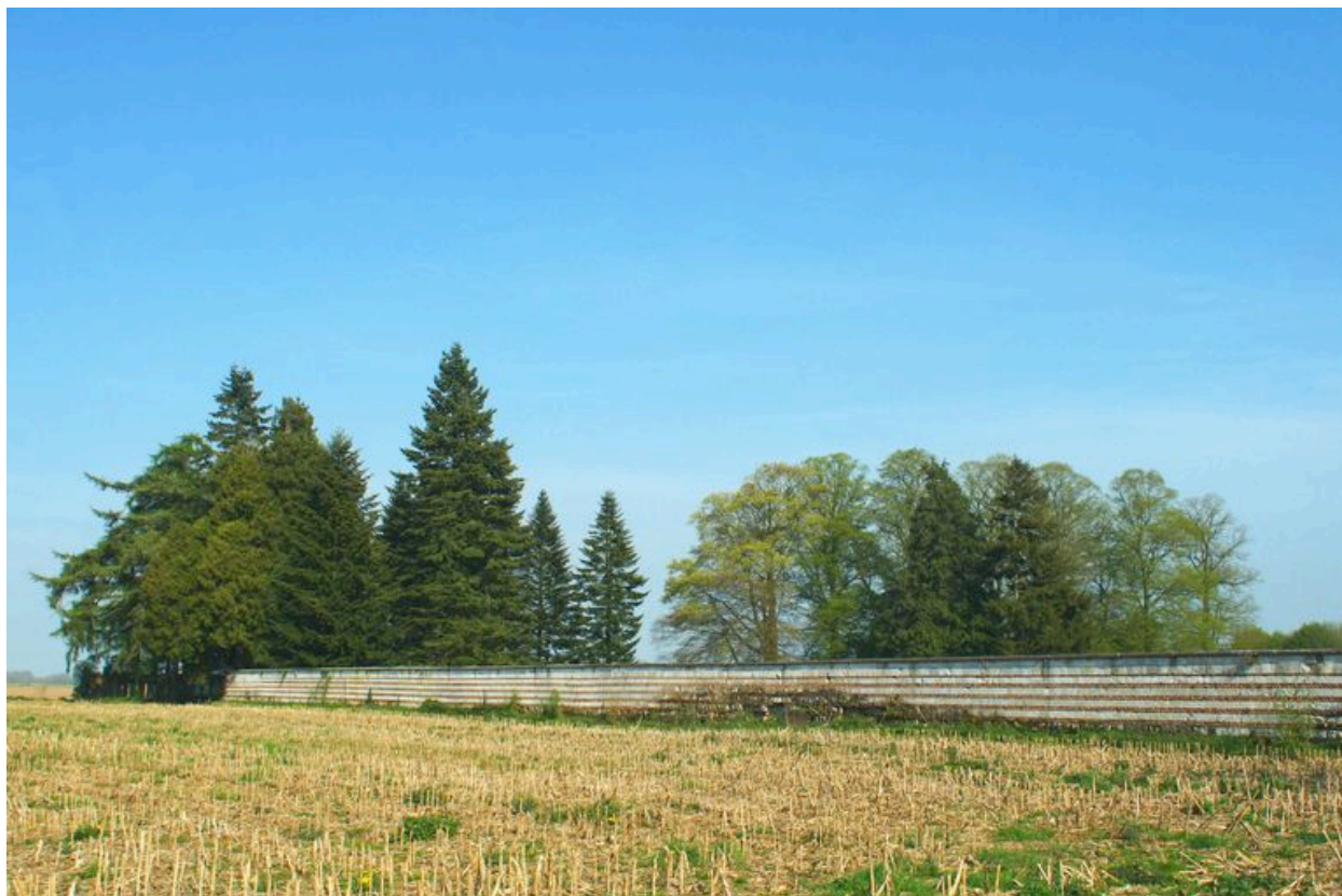
Mur de clôture du parc au nord.
