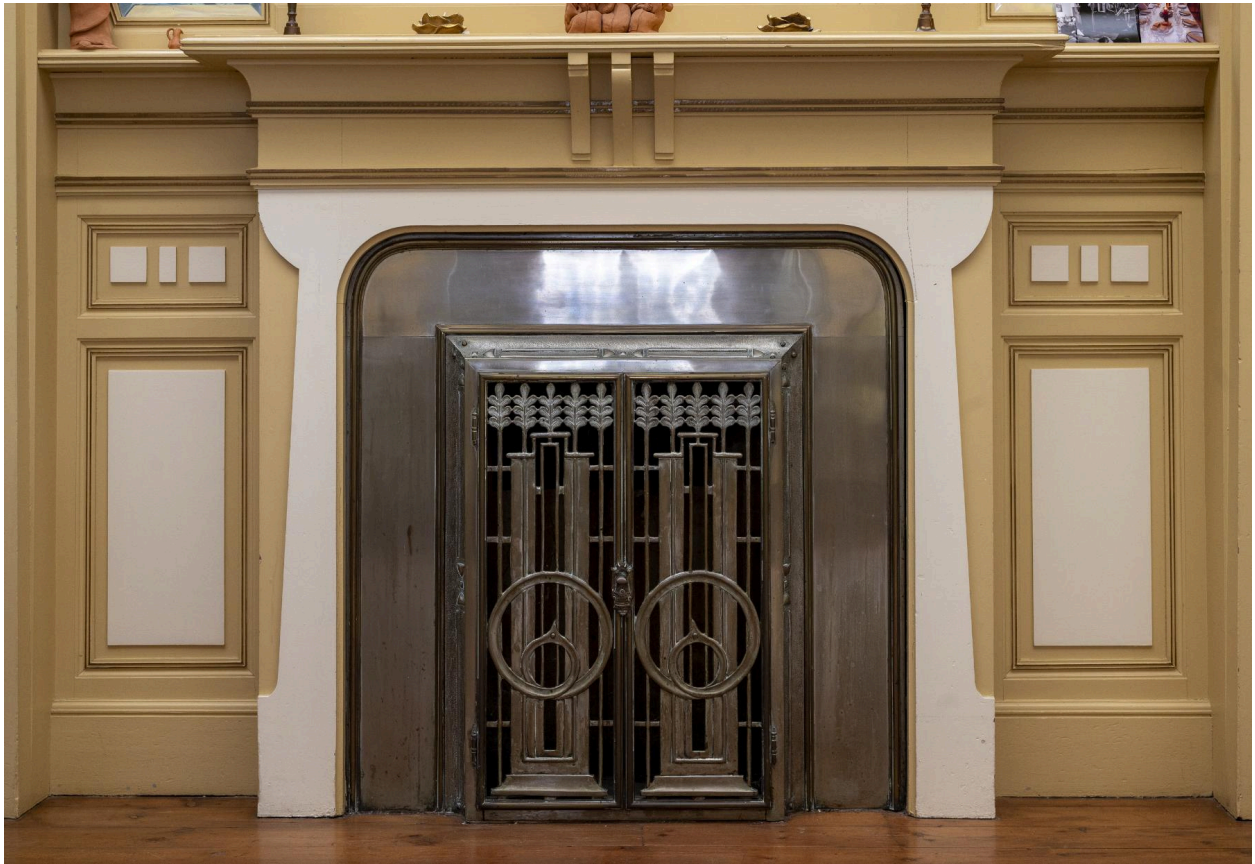
Détail du devant de cheminée de la cheminée de la salle à manger.
