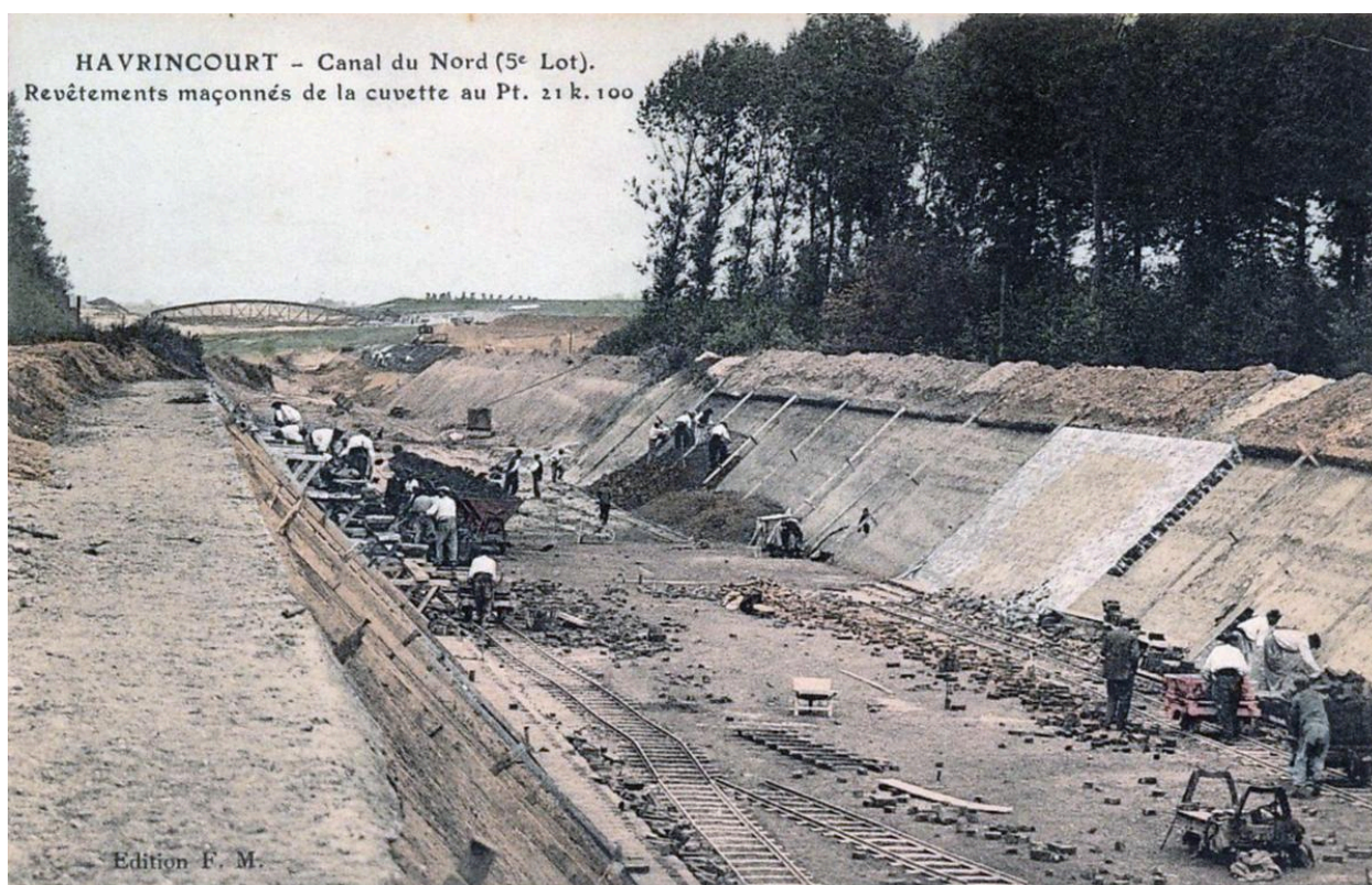
Chantier du canal du Nord. Travaux de revêtement de la cuvette maçonnée du canal à Havrincourt (Pas-de-Calais), entre 1908 et 1914 (collection particulière).
