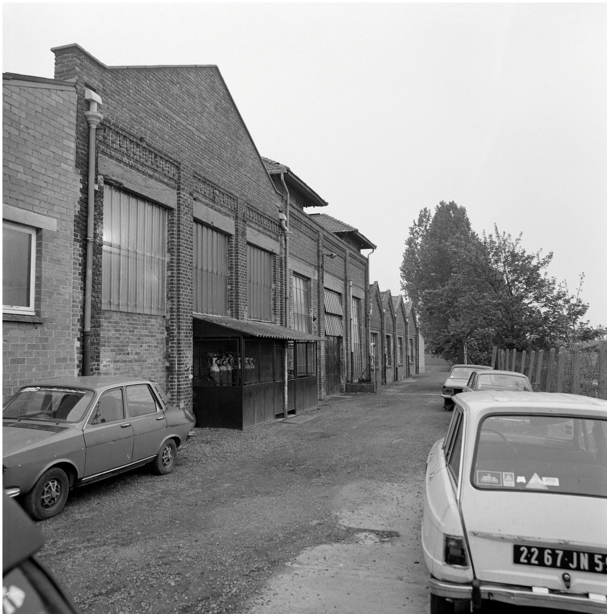
Elévation ouest. Façade sur la Lys, atelier de débouillissage.
